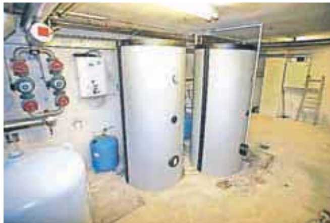
V strojnico so namestili skupni bojler za vsa stanovanja, ki ima zmogljivost dvakrat po osemsto litrov.
